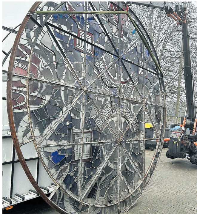
Hermann und Thorsten Fimpeler haben das prägnante Rundfenster aus der Laurentius-Kirche ausgebaut. Eine Arbeit für Spezialisten.
