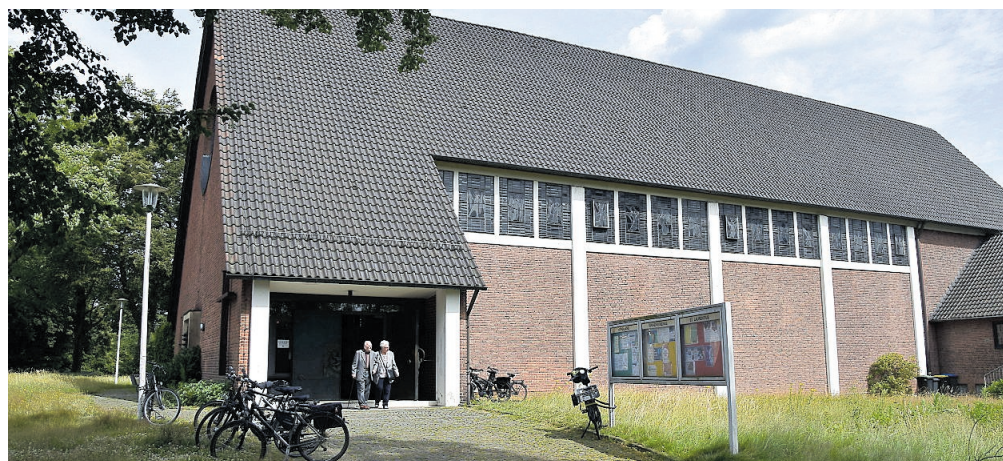
Soll noch in diesem Jahr abgerissen werden: die St. Laurentiuskirche in Haltern.
