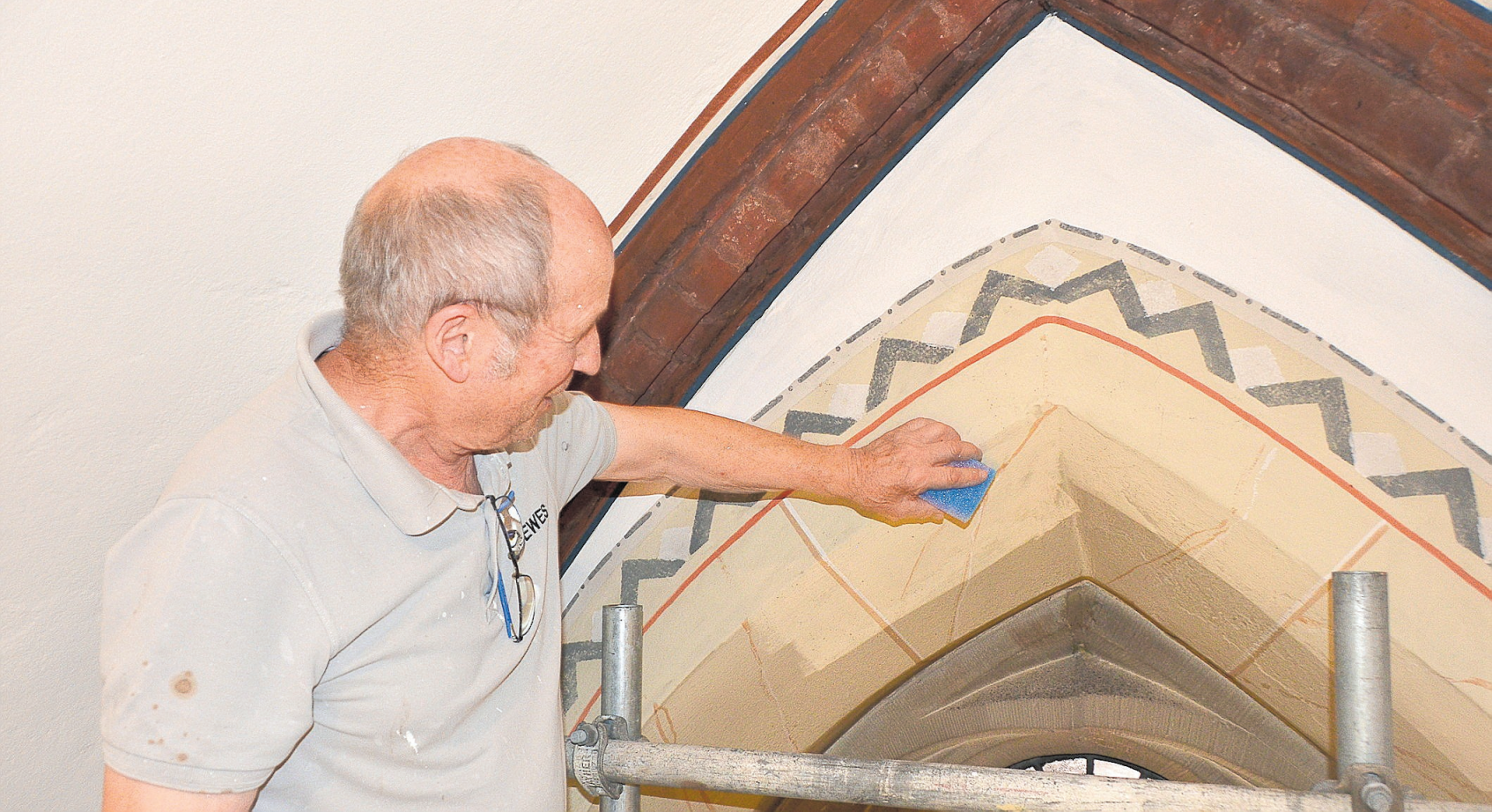
Seit Ostern läuft die Renovierung der Halterner St. Sixtus-Kirche. Horst Neumann reinigt mit einem Schwamm Fensterlaibungen und Wände. Die Schattierungen auf dem Sandstein zeigen, wie Ruß die Kirche verunreinigt hat.
