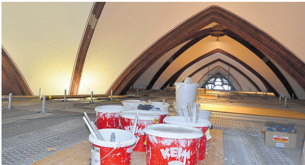
Hoch oben auf dem Gerüst stehen die Farbeimer bereit. Die Keimfarbe wird aufgebürstet.
